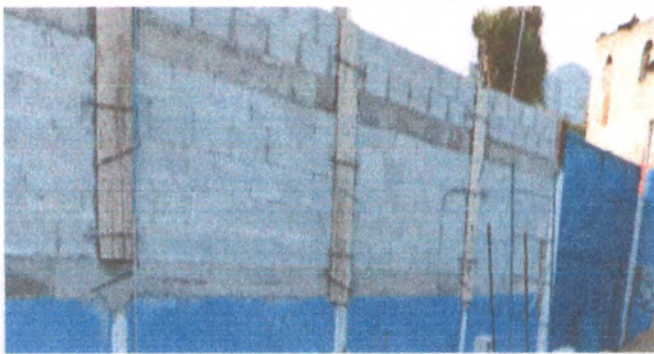
Foto 3: Reparación de muro perimetral de block en el establecimiento.
