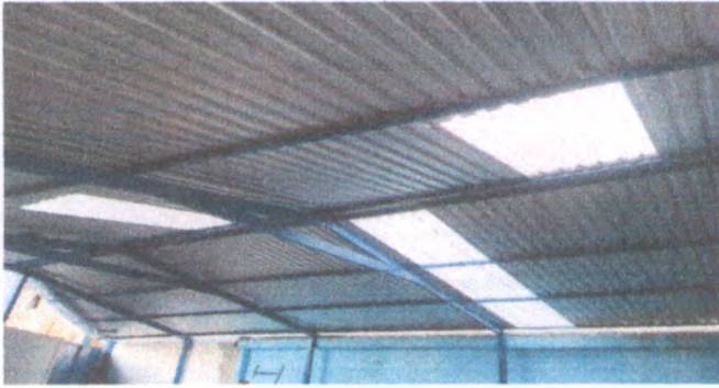
Foto 1: finalización de Sustitución de lámina, por lámina troquelada aluzinc calibre 26, en el patio del establecimiento.
