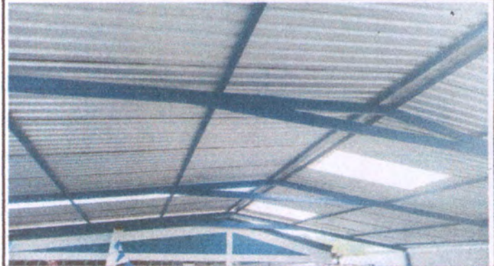
Foto 2: Finalización de sustitución de estructura de soporte de metal por metal en el patio del establecimiento.
