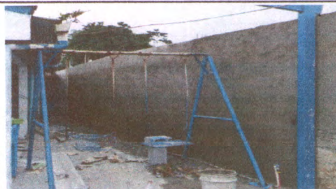
Foto 8: finalización de Repello en muro y alisado en muro perimetral.
